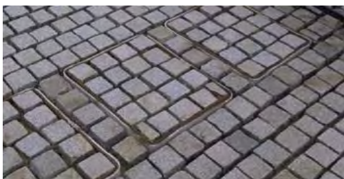
Abb. 21 Abdeckung über den Plattensensoren in der Pflasterung
